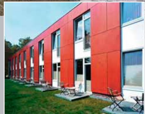
Altenwohnheim in Schwerin
